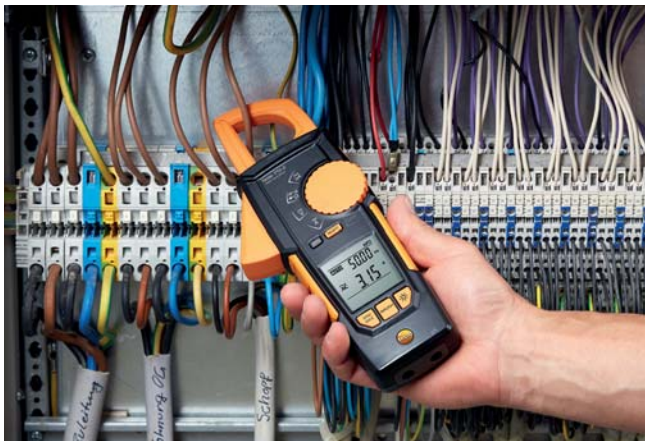
분전함의 전류 측정
