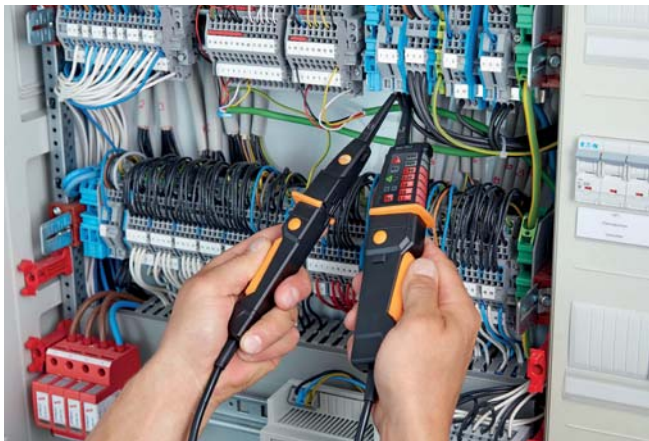
배전함의 전압 측정
