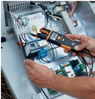
압축기의 전압 측정
